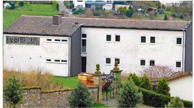
Blick auf das ehemalige Schwesternhaus in Tholey. Das Gebäude soll abgerissen werden.
